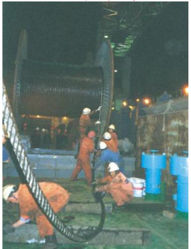
MTC为亚洲最大、世界第二的3800吨浮吊的直径65mm钢丝绳探伤，保证中海油海上工作安全。
